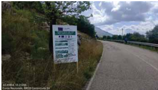
SP 12 a ANTE INIZIO – decesp. Scarpate stradali - FOTO N. 14
