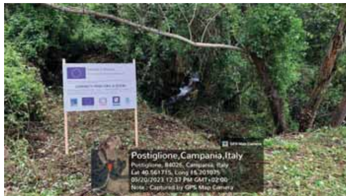
FINE - POST Ripristino funzionalità valloni - FOTO n. 31
